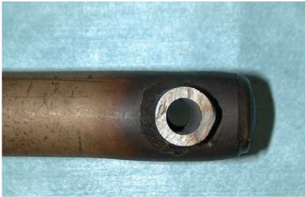
PM 15903 - Spezzone impianto Cheope soggetto a dilatazione della lega LBE
